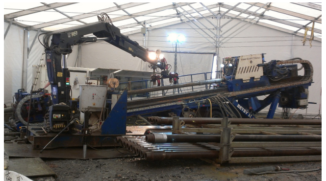
250 tons rigg borer og trekker Ø450 PE 1300 m lengde.
