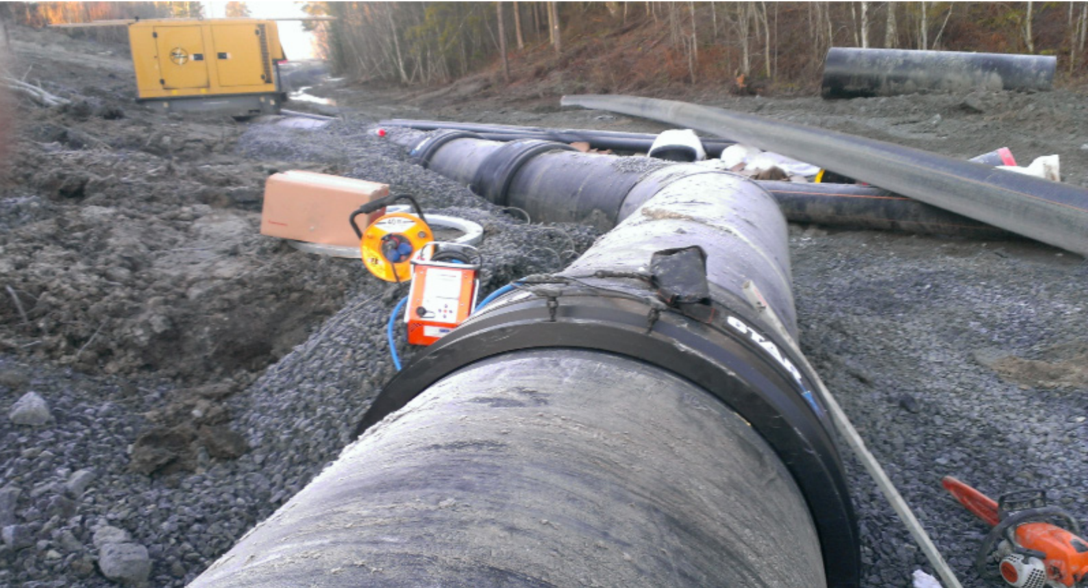
900 mm utslippsledning fra Tangen RA
