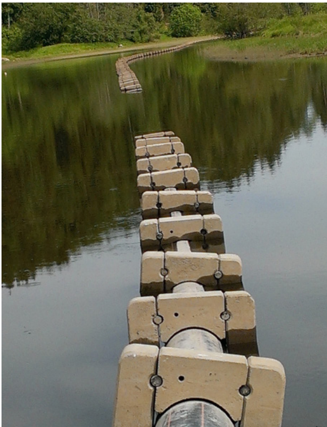
Ø450 mm rør vektet klar for senkning.
